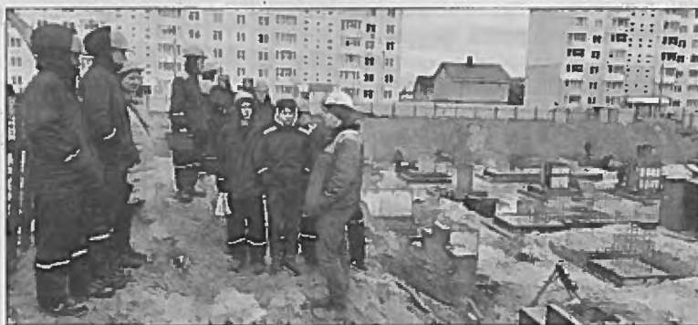
Будаб'ект «Школа ў 96-м мікрараёне Гомеля» — пляцоўка для практычных заняткаў будучых будаўнікоў.
